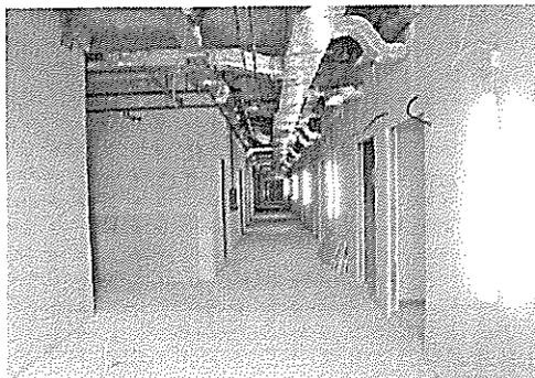
parapetti, i pavimenti in gres e pvc, mentre i controsoffitti del piano interrato sono al 70% di realizzazione e quelli del piano terreno al 15%. Completati, inoltre, la totalità degli impianti ed eseguito complessivamente dei 22 ascensori. Procedono, infine, con buone percentuali le concretizzazioni degli impianti elettrici, meccanici e degli impianti a gas tecnici e medicali. Insomma i lavori per il Policlinico dei Castelli non si fermano. Una volta aperto e operativo, il grande presidio
